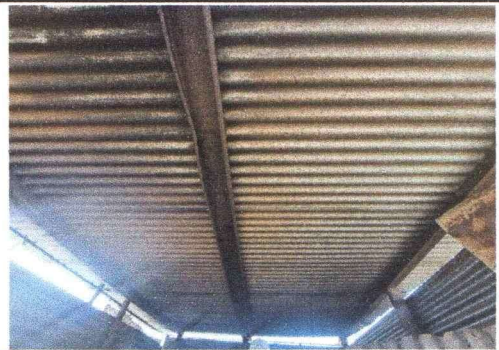
Foto 4: Sustitucion de techo de lamina por lamina troquelada aluzinc
