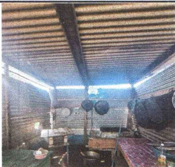
Foto 5: Instalacion y sustitucion de la red de electricidad
