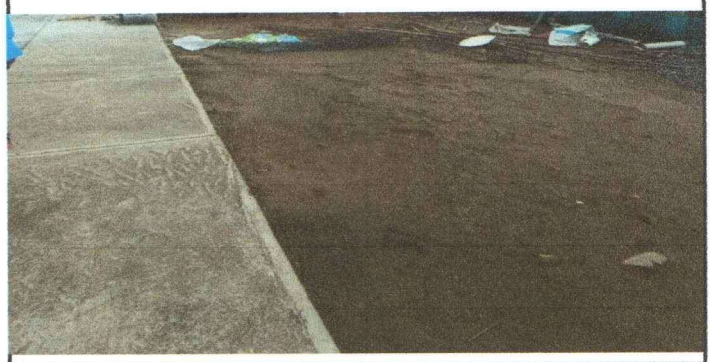
Foto 8: colocacion de torta de cemento
