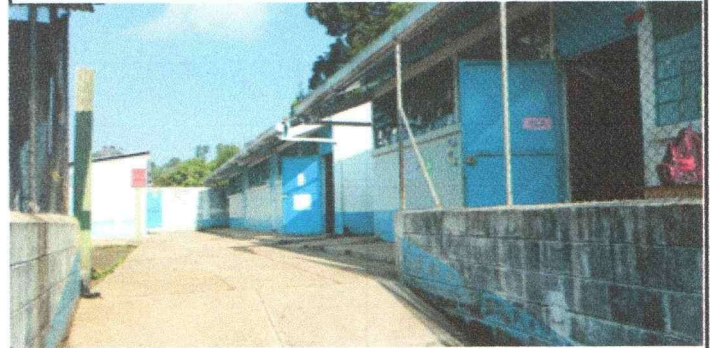
Foto 10: Pintura en muros interiores y exteriores
