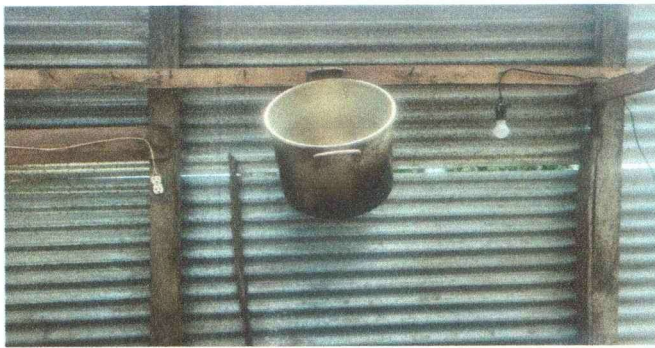
Foto 9: Reparación de Sistema Eléctrico
