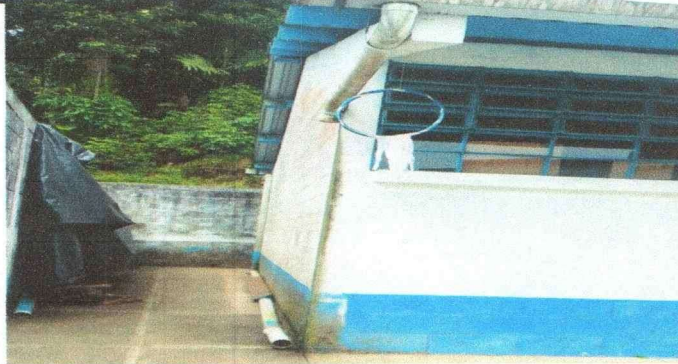
Foto 13: Reparación de bajada de agua pluvial a tubo pvc
