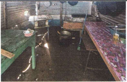
Foto 6: Aplicación de piso
