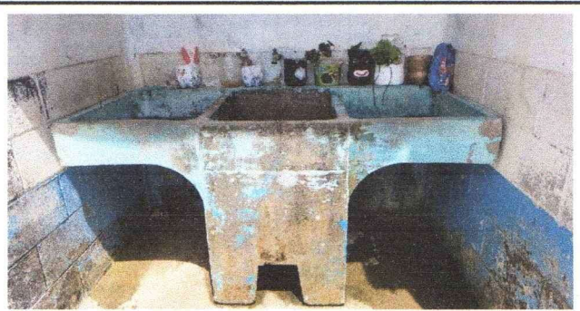
Foto 2: Sustitucion de pila de cemento de dos lavaderos
