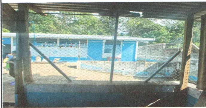
Foto 7: Sustitucion de estructura de metal por ventana
