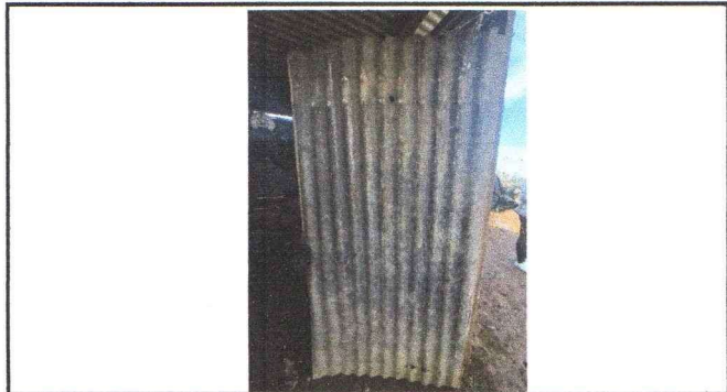
Foto1: Sustitución de puerta de metal
