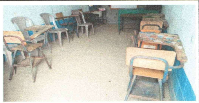
Foto 12: Sustitución de piso cerámico
